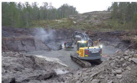
Schakt för fundament
