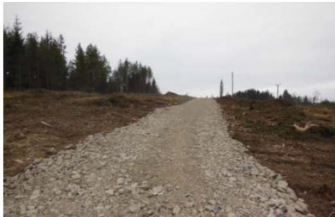
Byggvägar av stenkross med geotextil i botten
