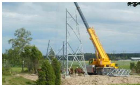
Resning av stolpe med mobilkran
