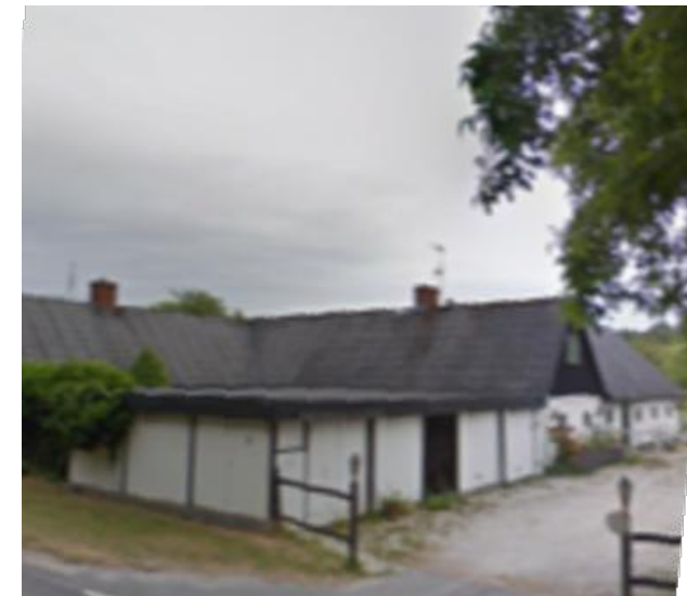
FOTO AV BEF FÖRRÅDSBYGGNAD, SOM RIVNINGSANSÖKAN AVSER.
