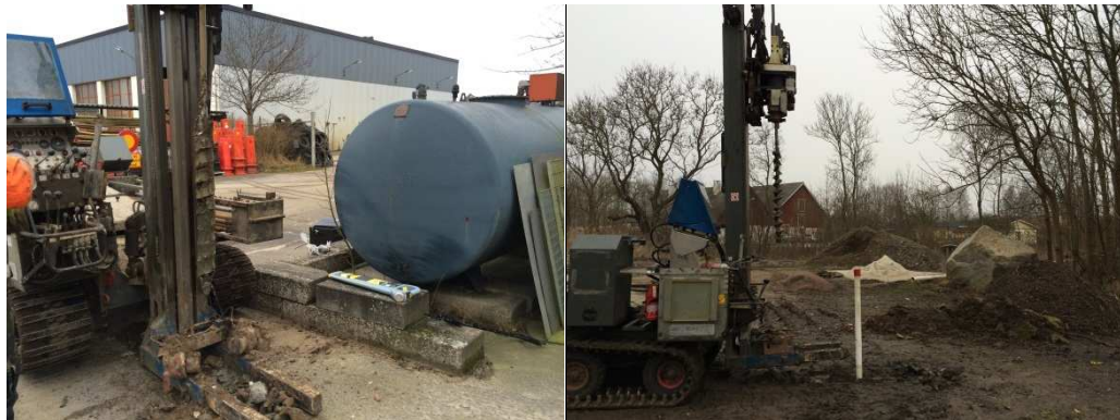
Figur 4. Bilden till vänster visar borrhypunkt 15ÅF02 vid ovanjord cisternen medan bilden till höger visar det installerade grundvattenröret i borrhypunkt 15ÅF04. (Foto: ÅF Infrastructure AB, 2015)
