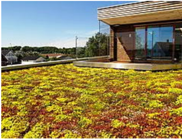
Figur 10: Exempel på sedumtak.
