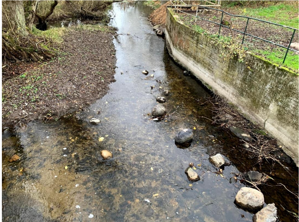
Figur 3. Nordligaste åfåran nedan bron efter sanering. Foto 2020-11-10.
