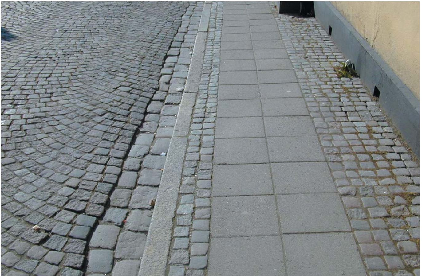
En typisk kombination av smågatsten, betongplattor och storgatsten för gator i Lunds stadskärna. (Winstrupsgatan)
