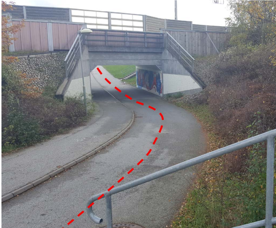
Figur 4 Mittlinje på cykelvägen föreslås, samma tjocklek och storlek men enligt skissen är vägmarkeringen inte det.
