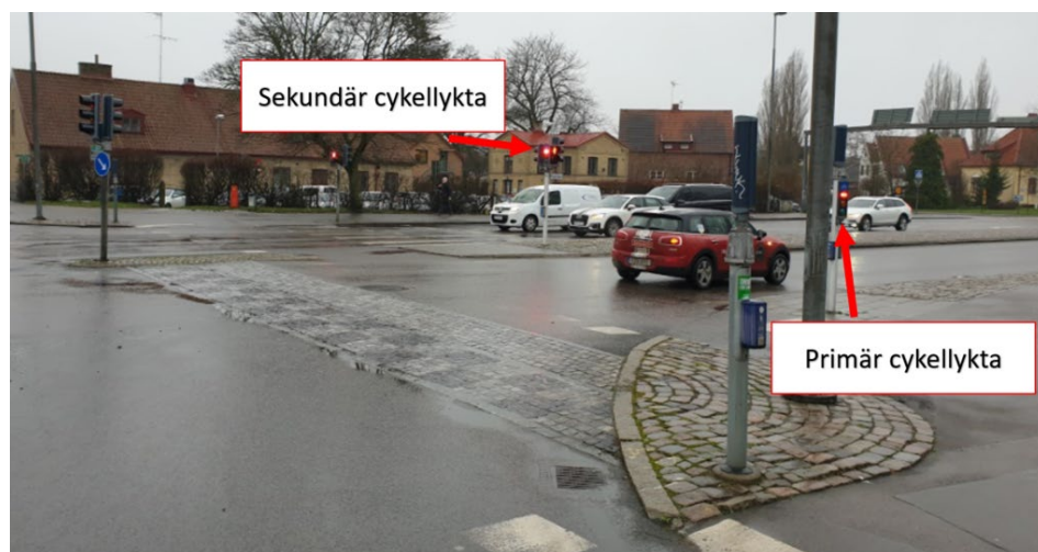
Bild 1 Korsning Stora Södergatan - Ringvägen i Lund. Sekundär cykellykta installerades under 2020 för att uppmärksamma högersvängande fordon från Stora Södergatan på att cyklister har grönt.
