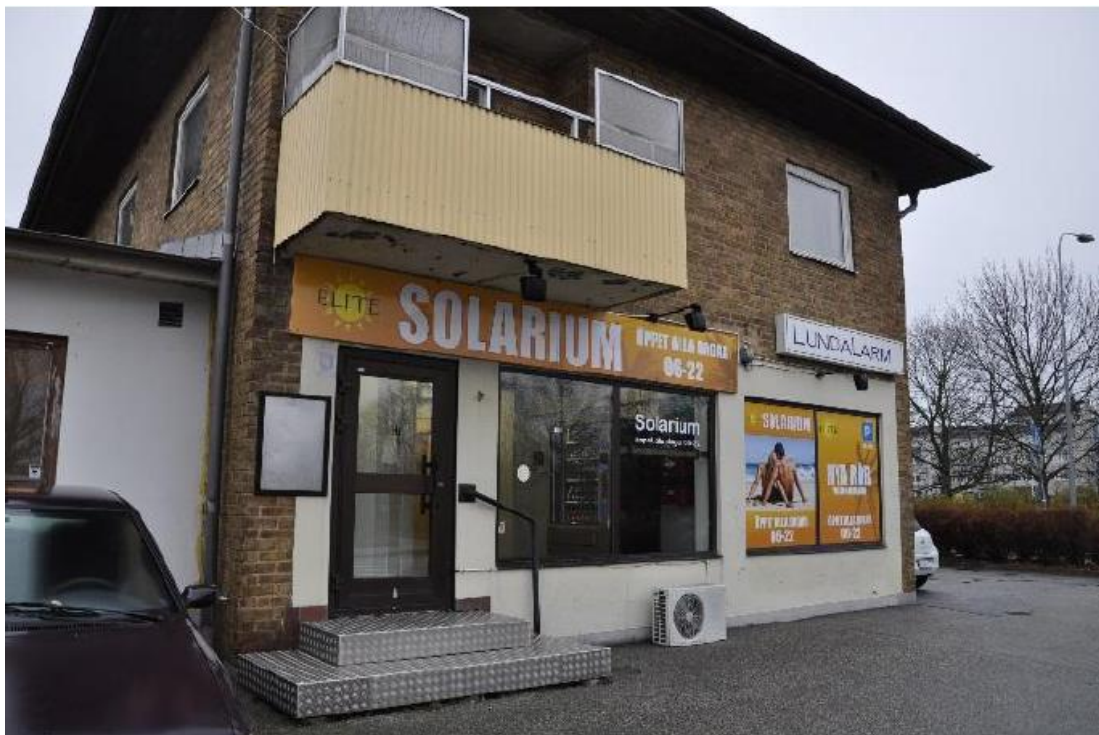
Tvåvåningshusets fasad mot söder, bild från den fördjupade antikvariska förundersökningen.
