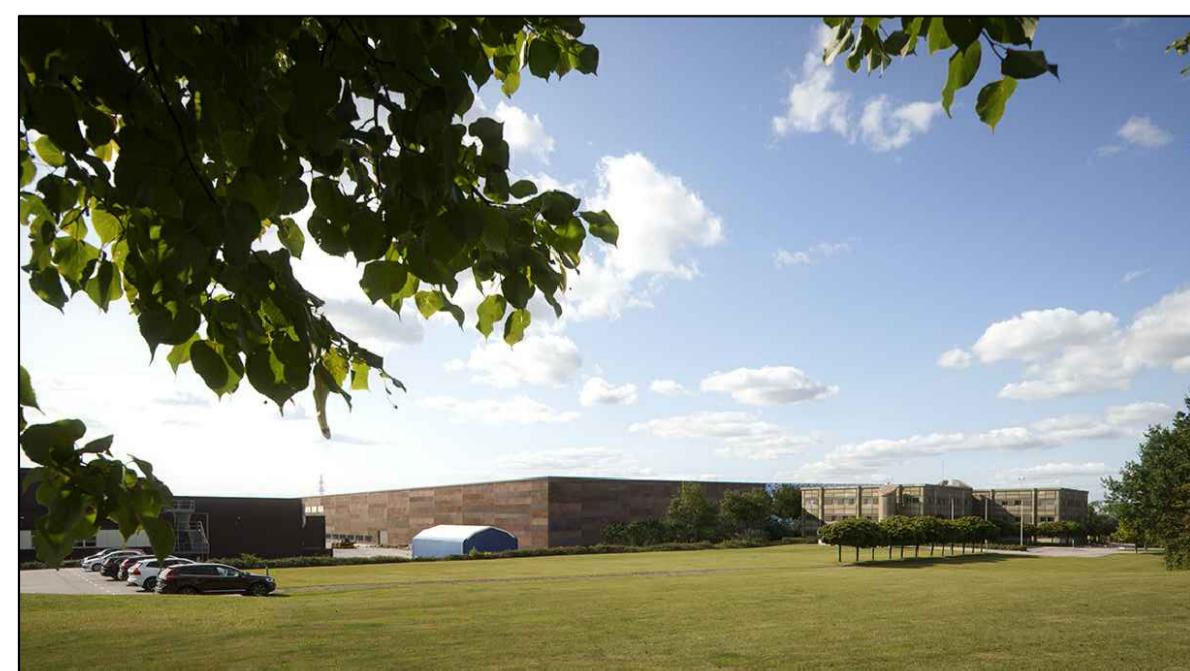
3D vy över anläggningen från Rudeboksvägen (markering B)
